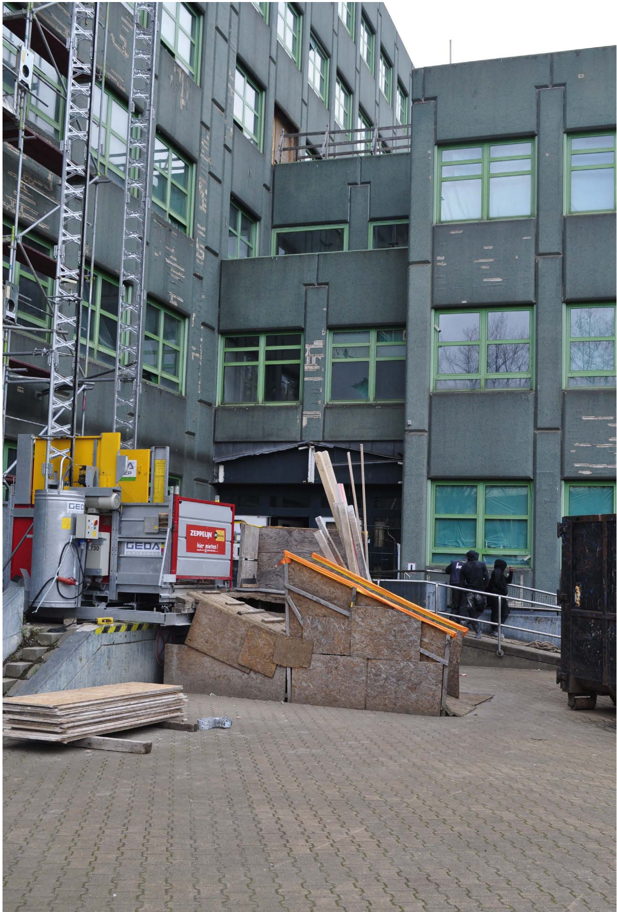
Während der Rückbauarbeiten der leichten Einbauten
