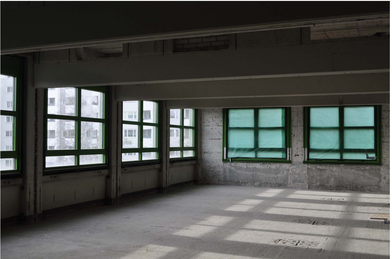
Nach Entfernung der leichten Bauteile bleibt der Rohbau aus Stahlbeton
