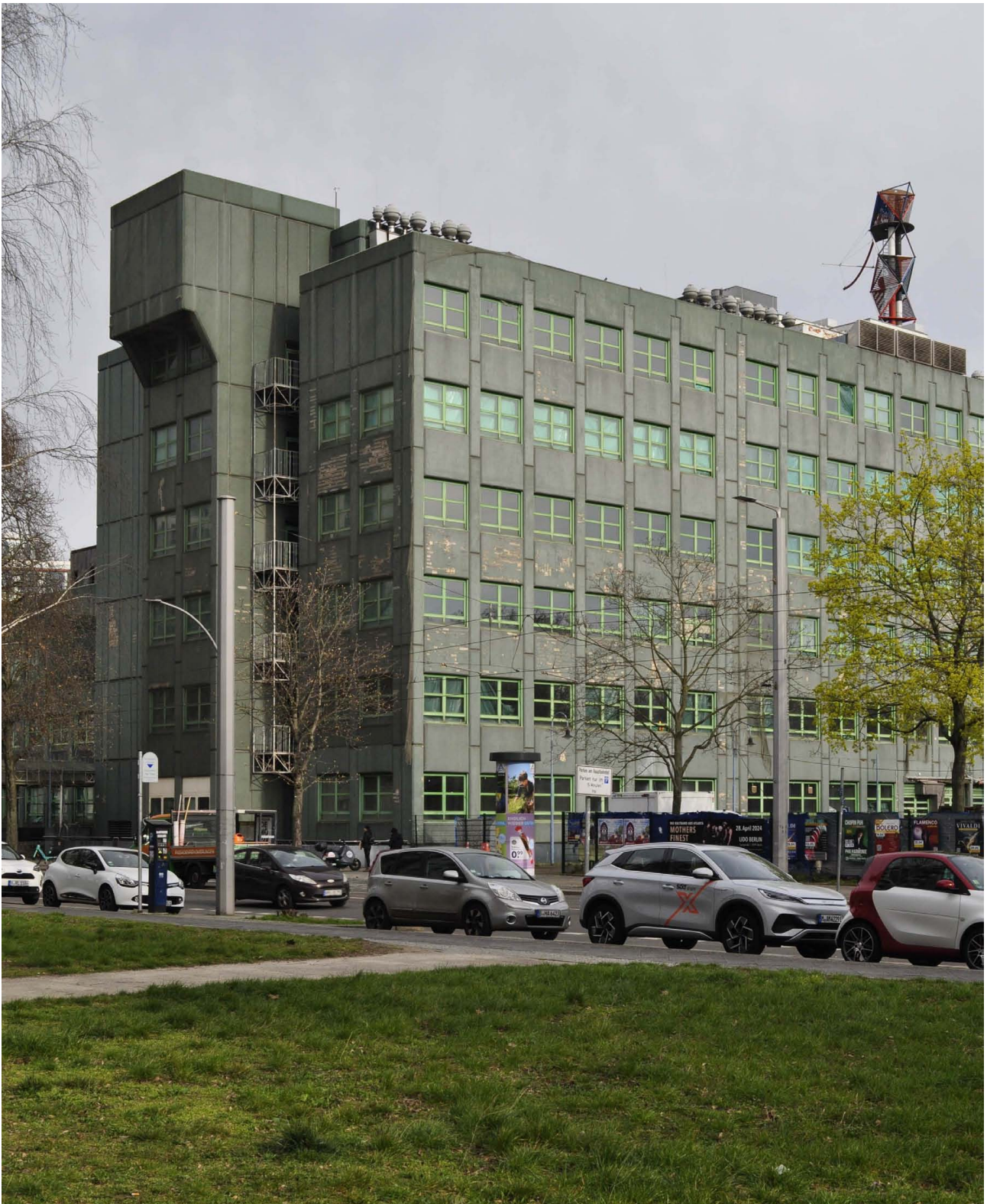
Ansicht von der Invalidenstraße
